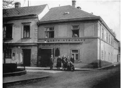
Abb. 21: das Gasthaus „Zu den 3 Raben“ nach der Aufstockung, nach 1928
